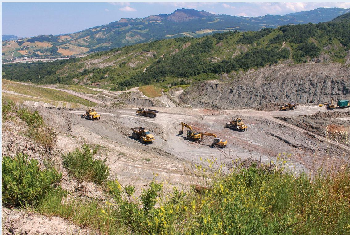
Figura 6-2: Equipos de construcción excavando en un área de tierra.
